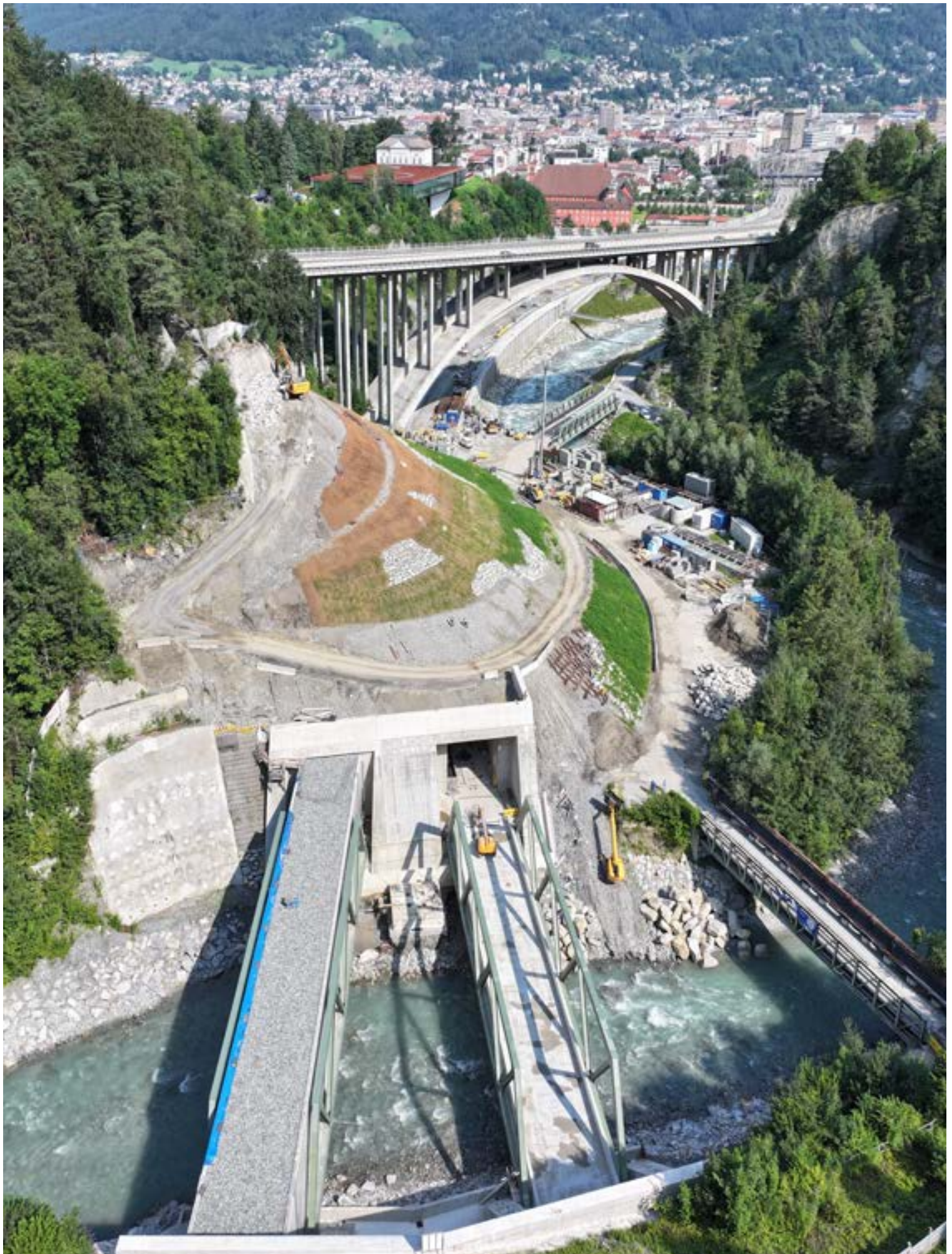
Zwei Eisenbahnbrücken über die Sill binden das Nordportal an, Oktober 2023 Due ponti ferroviari sopra il Sill collegano il portale nord, ottobre 2023
