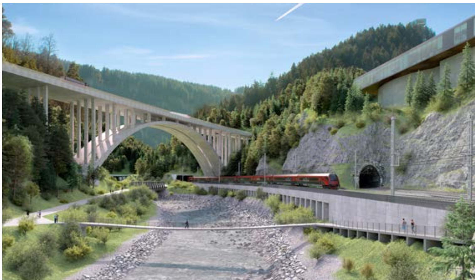
Blick Richtung Süden in die neu gestaltete Sillschlucht hinein Vista verso sud nella Gola del Sill in nuova configurazione
